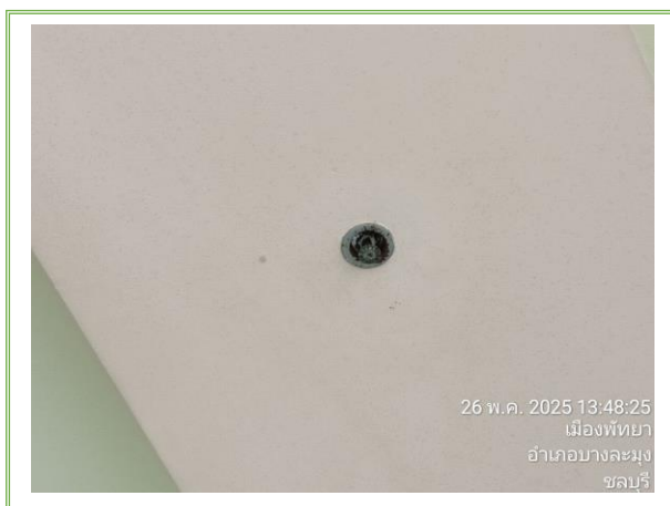
รูปที่ 3-27 Sprinkler
